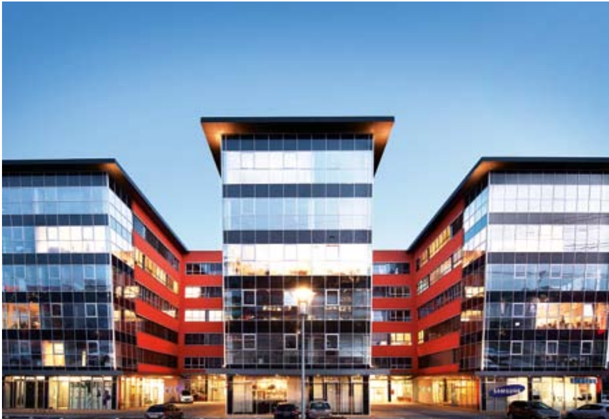
Bürogebäude Galvaniho 4, Bratislava, Slowakei
