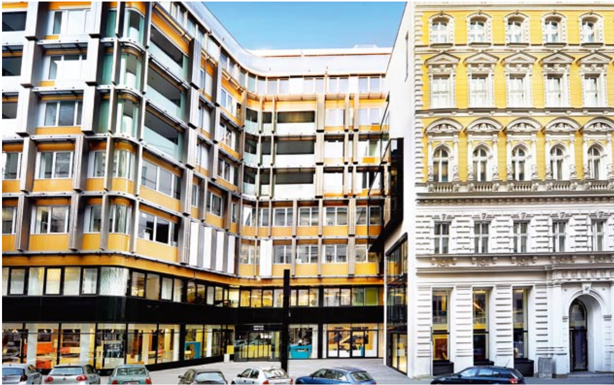
Büro- und Wohngebäude Neutor 1010, Wien, Österreich
